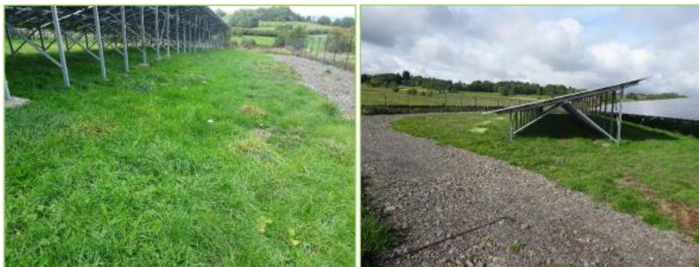
Exemples de voiries sur des parcs photovoltaïques construits par Luxel
